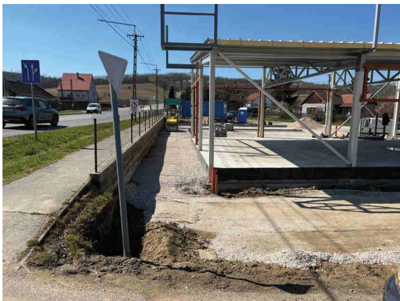
épülő áruház és az előkert a déli oldalon
